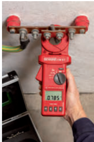
Messung des Erdschleifenwiderstandes eines Anlagenerders
